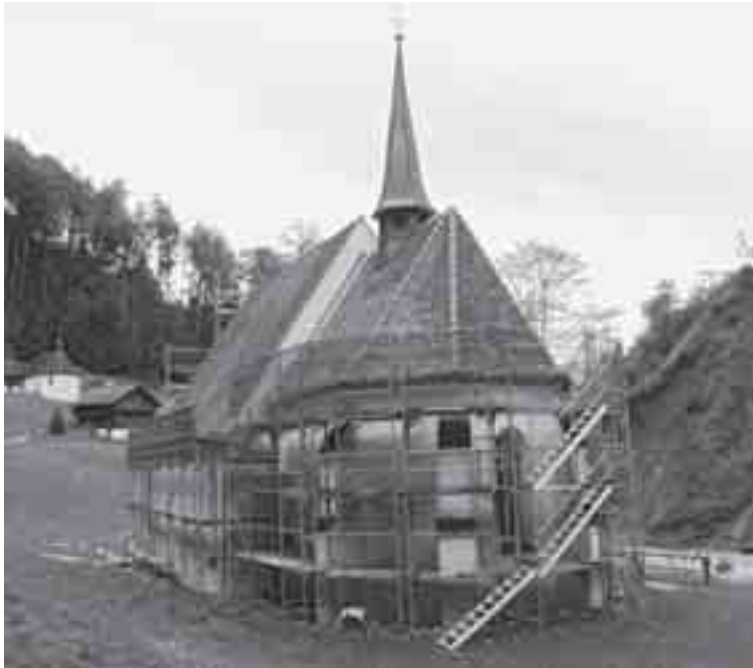
Die untere Ranftkapelle wird noch bis Ende Oktober für über eine halbe Million Franken renoviert. (Bild: Josef Reinhard)
